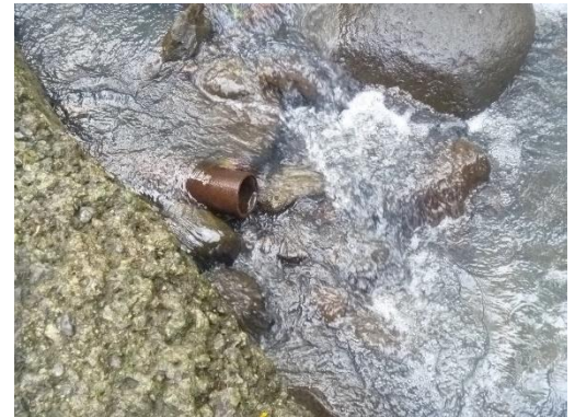
Figure 3.11 - Canalisation en aval du point Aval_éloigné
